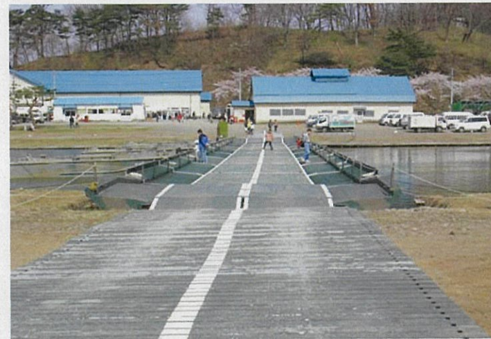
応急橋を架設
